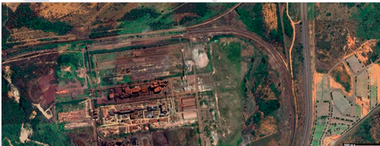
Figura 2. Patio de Aditivos y Pila de Almacenamiento. Fuente: (Google Maps, 2025).
